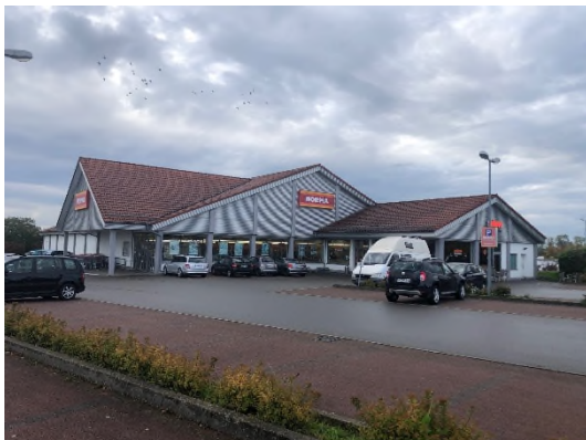
Norma-Bestandmarkt mit Anbau Bäckerei
